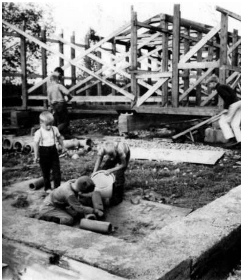
Birgittas och Hampans söner bygger med lägerpojarna på Hamregården
