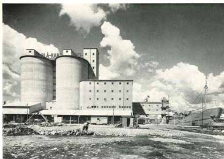
Distributionsanläggningen på Lövholmen. Silorna rymma tillsammans 28 000 ton och de tre packmaskinerna kunna packa 4 000 säckar per timme.
